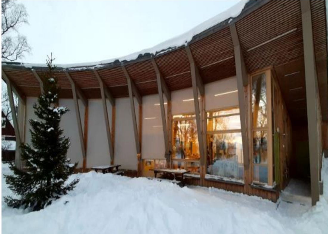
Figura 12 - Casa da Praia, aspeto exterior.
