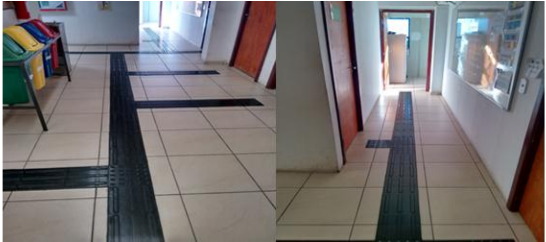
Figura 10. Piso tátil instalado no Campus Do arquivo da autora
