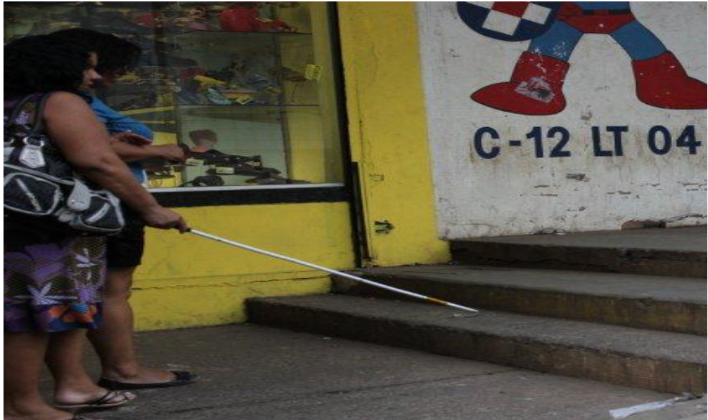
Figura 6. Escadas em frente à entrada do Campus Taguatinga Centro do prédio antigo.
