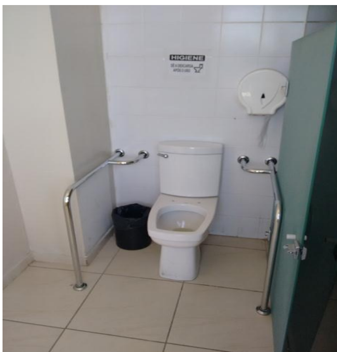
Figura 12. Banheiro acessível Do arquivo da autora
