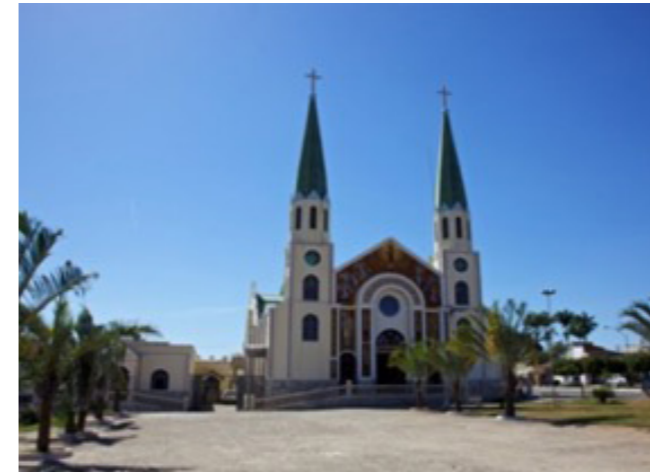
Figura 4: Fachada atual da Igreja Nossa Senhora da Penha. Fonte: acervo de Francisco Aragão.
