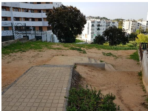
Figura 125 – Escadas para acesso às estruturas do piso inferior.
