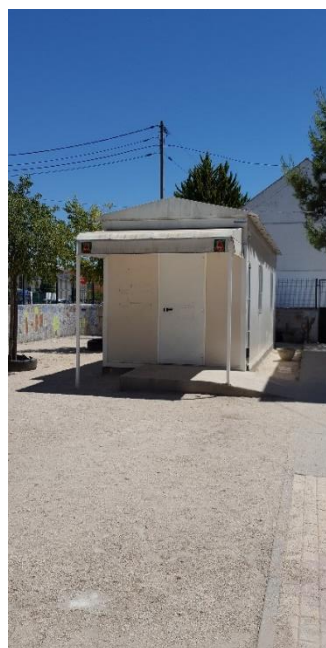
Figura 66 – Casa de arrumações.
