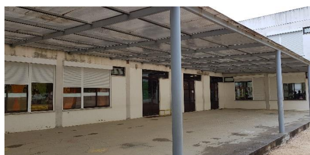
Figura 139 – Alpendre da parte de trás.
