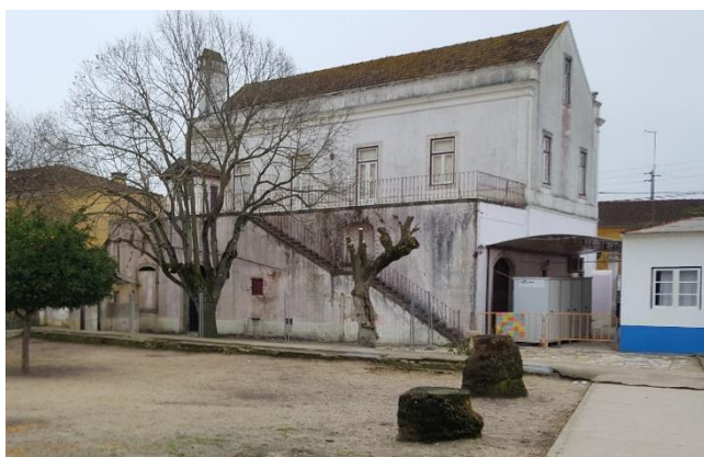
Figura 94 – Edifício da escola antiga.
