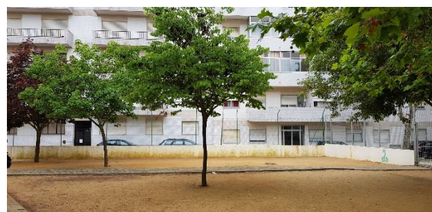
Figura 140 – Portão com caminho.
