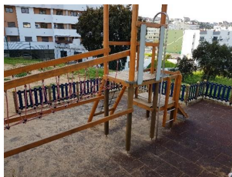
Figura 126 – Estruturas no piso inferior.
