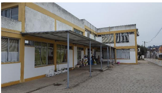
Figura 105 – Alpendre da entrada do edifício da escola.
