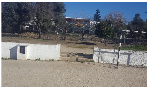
Figura 98 – Escada de acesso à área numerada 5.
