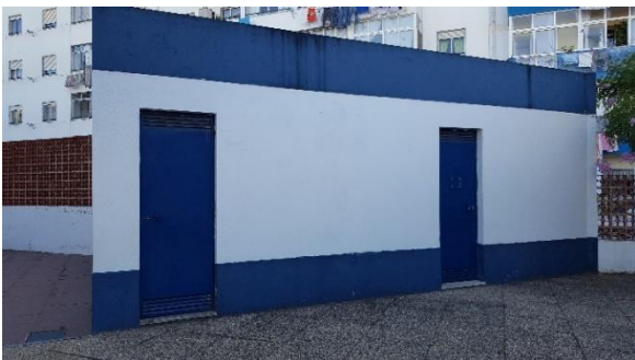
Figura 87 – Casa de arrumações.
