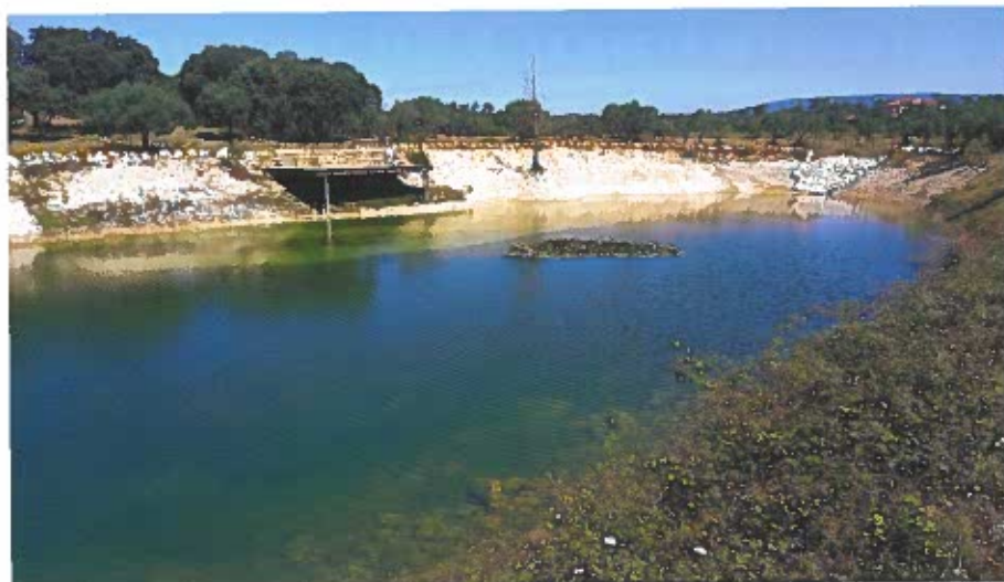
FIGURA 2. Bacia de recolha e retenção das águas pluviais na Vivid Farms.
