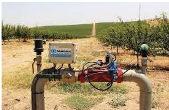
Figura 9 – Exemplo de um cabeçal de rega
