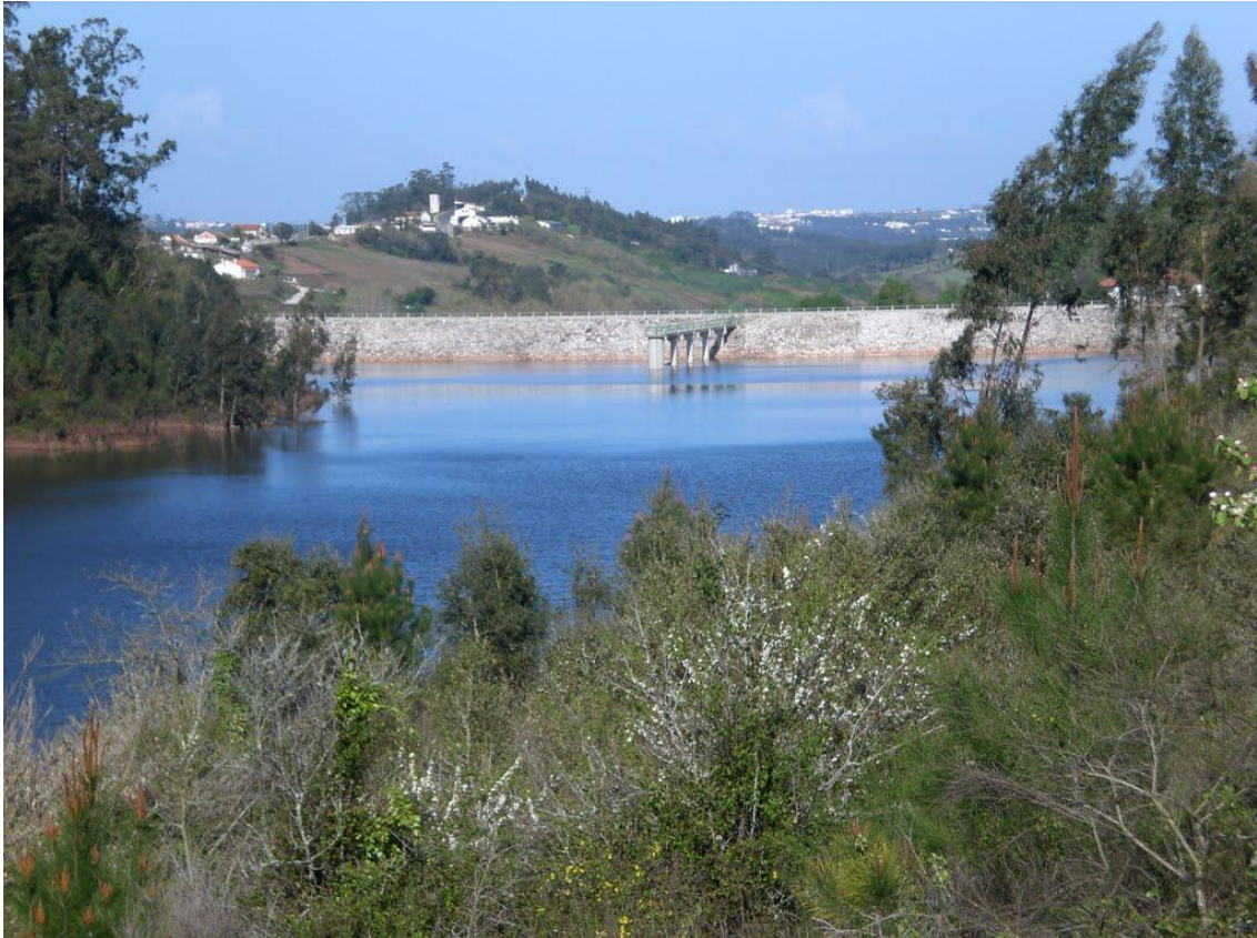
Figura 1 - Vista geral da barragem de Alvorninha
