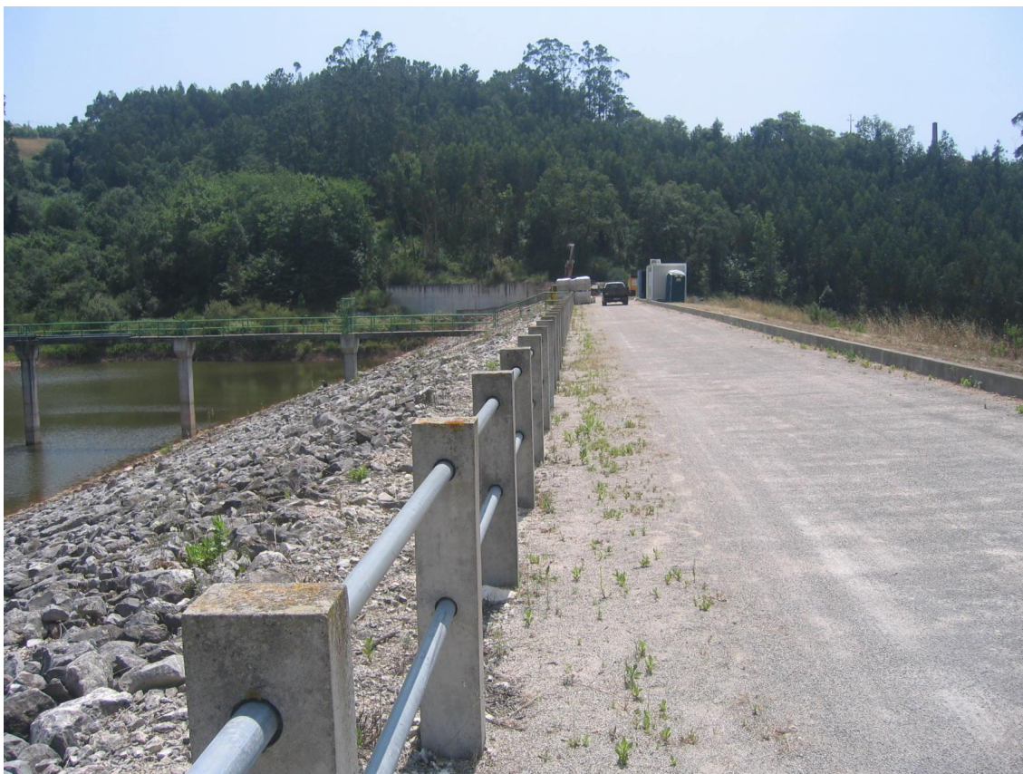
Figura 5 - Reparação da parede da barragem
