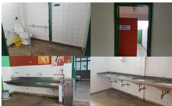
Imagem 11 – Sanitários e bebedouros do prédio anexo 2. Fonte: arquivo do autor.
