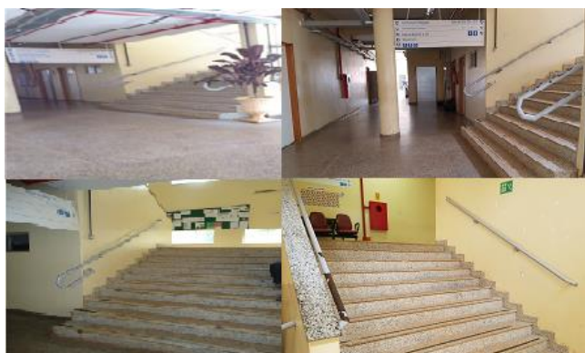
Imagem 8- acesso às salas de aula e auditório prédio principal do IFB-CPLA. Fonte: arquivo do autor.
