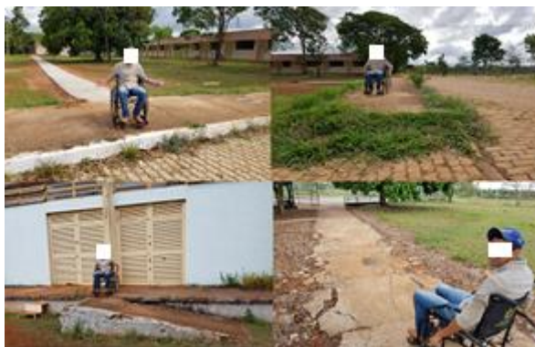
Imagem 17 – Calçamentos e rampas de acesso campus IFB-CPLA. Fonte: arquivo do autor.
