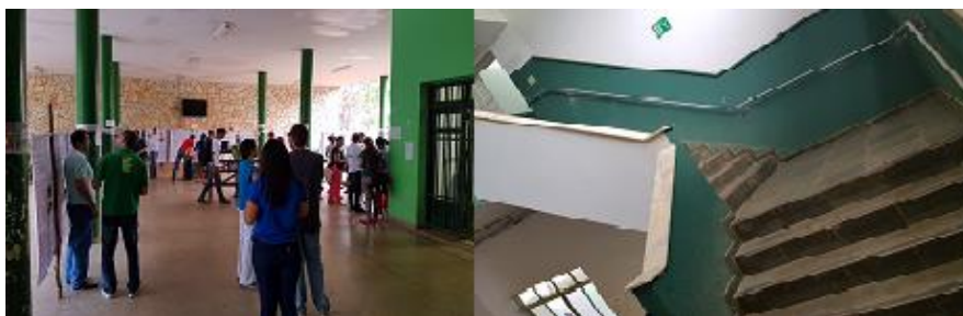
Imagem 10 – Pátio e escada de acesso auditório principal e direção e setor administrativo prédio anexo 2. Fonte: arquivo do autor.
