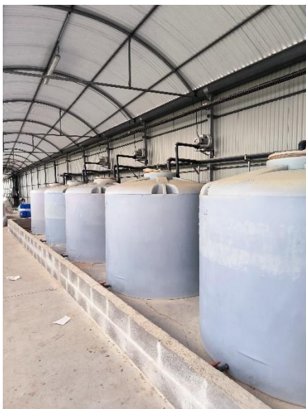
Figura 9 - Tanques de fertirrega, com capacidade de 5 mil litros cada
