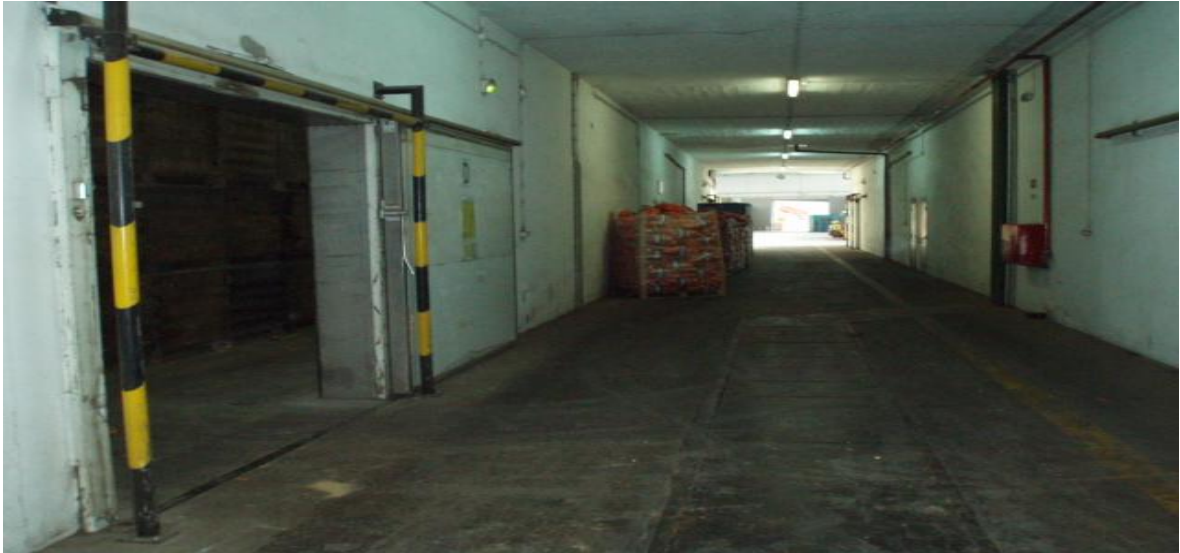
Figura 4 – Panorâmica geral das câmaras de conservação na central de armazenagem.
