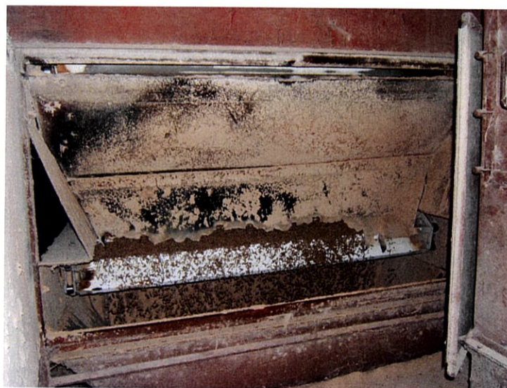
Figura 9- Vista geral do arrefecedor
