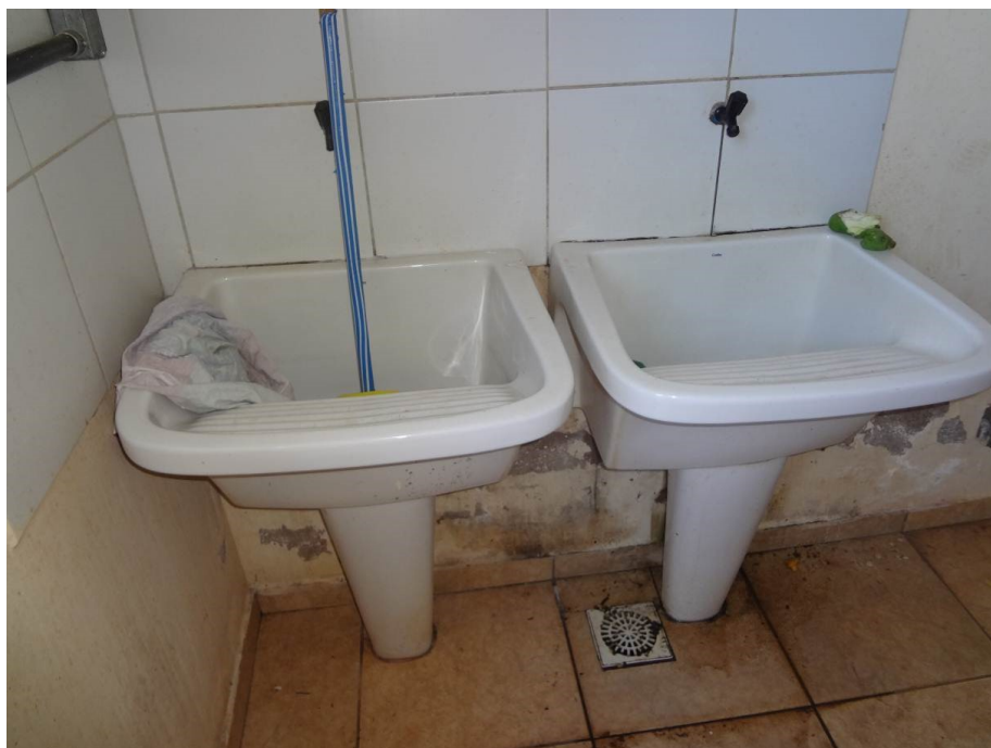
Condições de infraestrutura dos alojamentos
