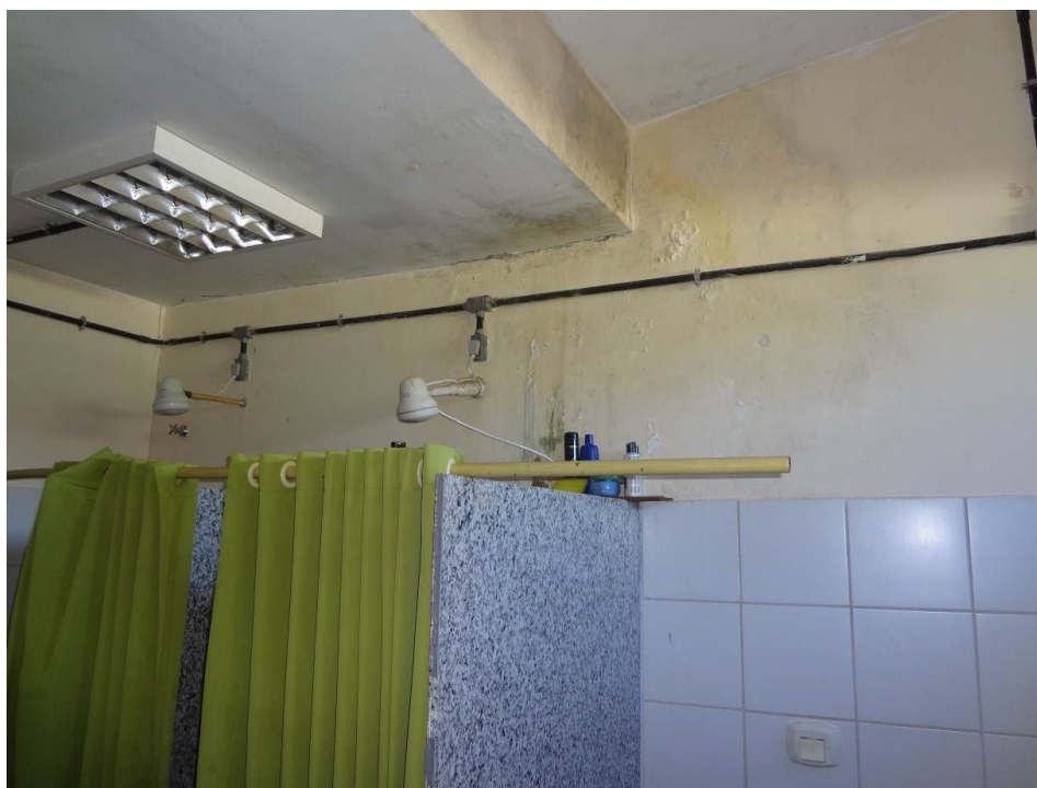
Condições de infraestrutura dos alojamentos
