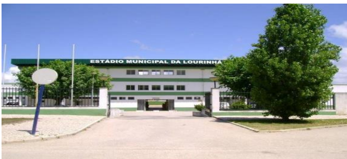
Figura 4. Infraestrutura – fachada do estádio
