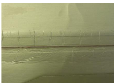
Figura 22: Centragem e soldadura
