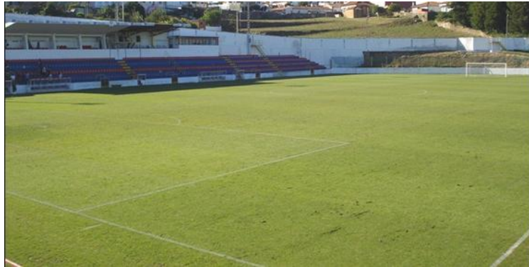
Figura 2 - Estádio Carlos Osório
