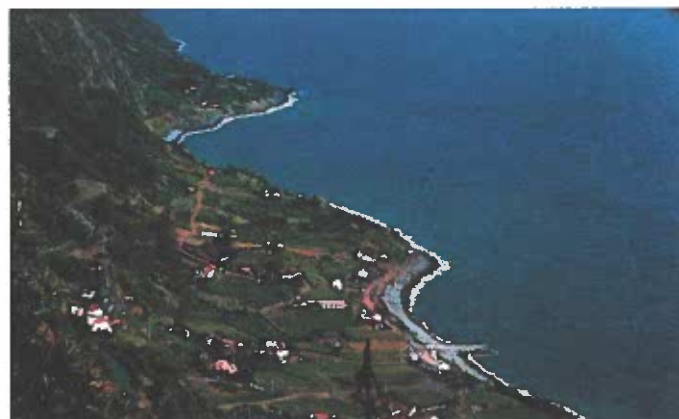
Depósitos na base de uma encosta
