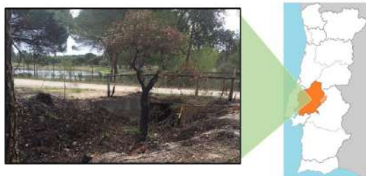
Figura 1 – Barragem do Zambujeiro atualmente (sem intervenção).
