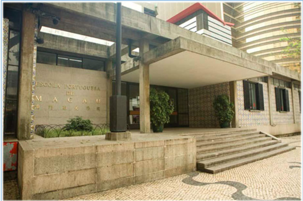
Figura 4 - Fachada principal da EPM vista da Avenida D. Henrique
