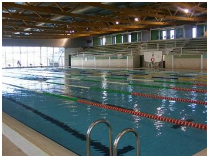
Figura 15. Piscina Olímpica de 50m de Rio Maior.
