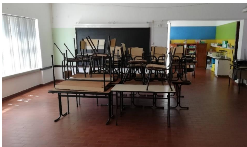
Figura 17. Espaço antes da transformação
